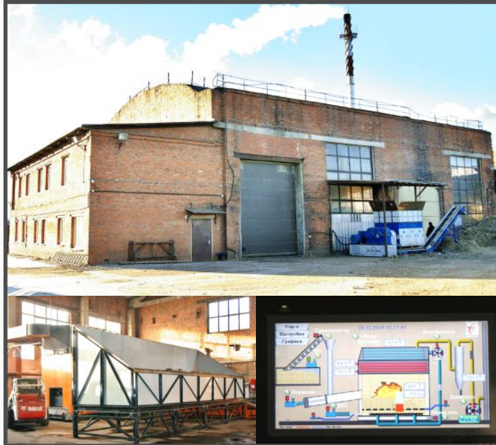
УТПУ-МТ 2МВт Московская обл.
